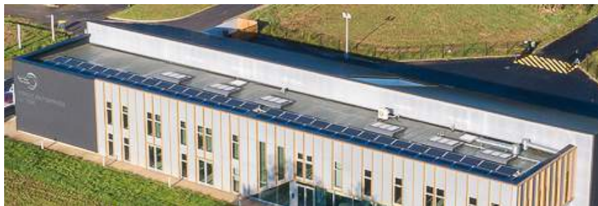
Un exemple d'installation de panneaux solaires sur la toiture de l'Espace entreprises Le Tissé situé dans le parc d'activités de la Gautrais à Montauban-de-Bretagne.
