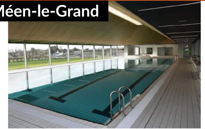
La maîtrise d'œuvre de ces travaux a été confiée au groupe RAUM/LEICHT France/TUAL/CMB35/cabinet conseil Vincent Hedont installé à Nantes. Ici, le bassin de nage.
