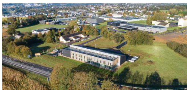
Le parc d'activités de la Gautrais à Montauban
