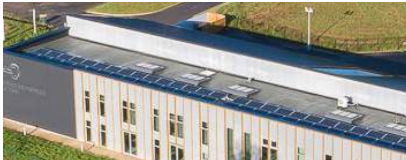
L'Espace entreprises Le Tissé bénéficie déjà de panneaux photovoltaïques.
