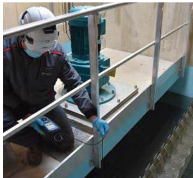
Contrôle de la qualité de l'eau à l'usine de production d'eau potable de Tizon.
