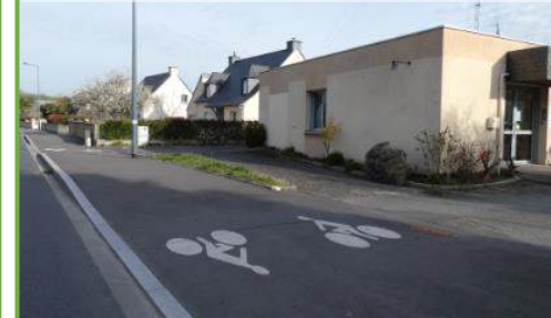
Voie verte Rue de la Croix du Passage à Saint-Méen
